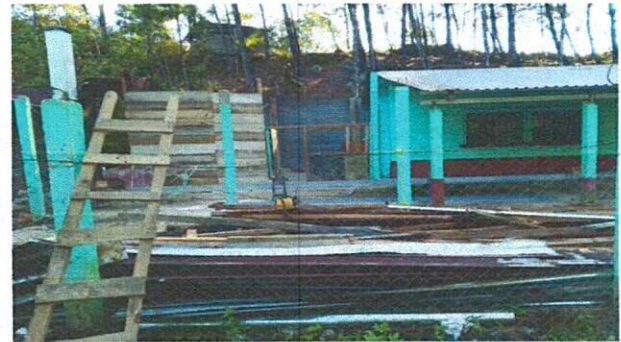
Foto 4: instalacion de techo de cocina
