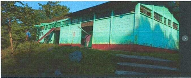
Foto 3: quitada de laminas en mal estado
