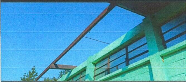
Foto1: instalacion de laminas del techo de salon
